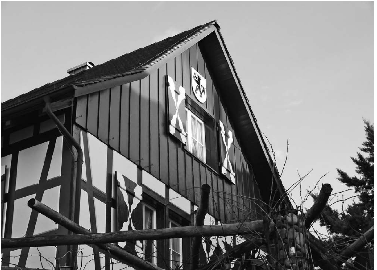
In der Bürgerrotte wird die Wohnung renoviert.
