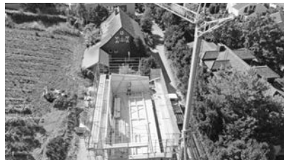
Aufrichtung des Holzbaus.
