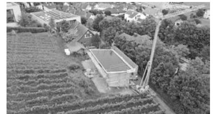
Die Photovoltaikanlage wird montiert.
