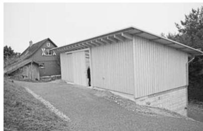
Die neue Remise, Ansicht von Norden.
