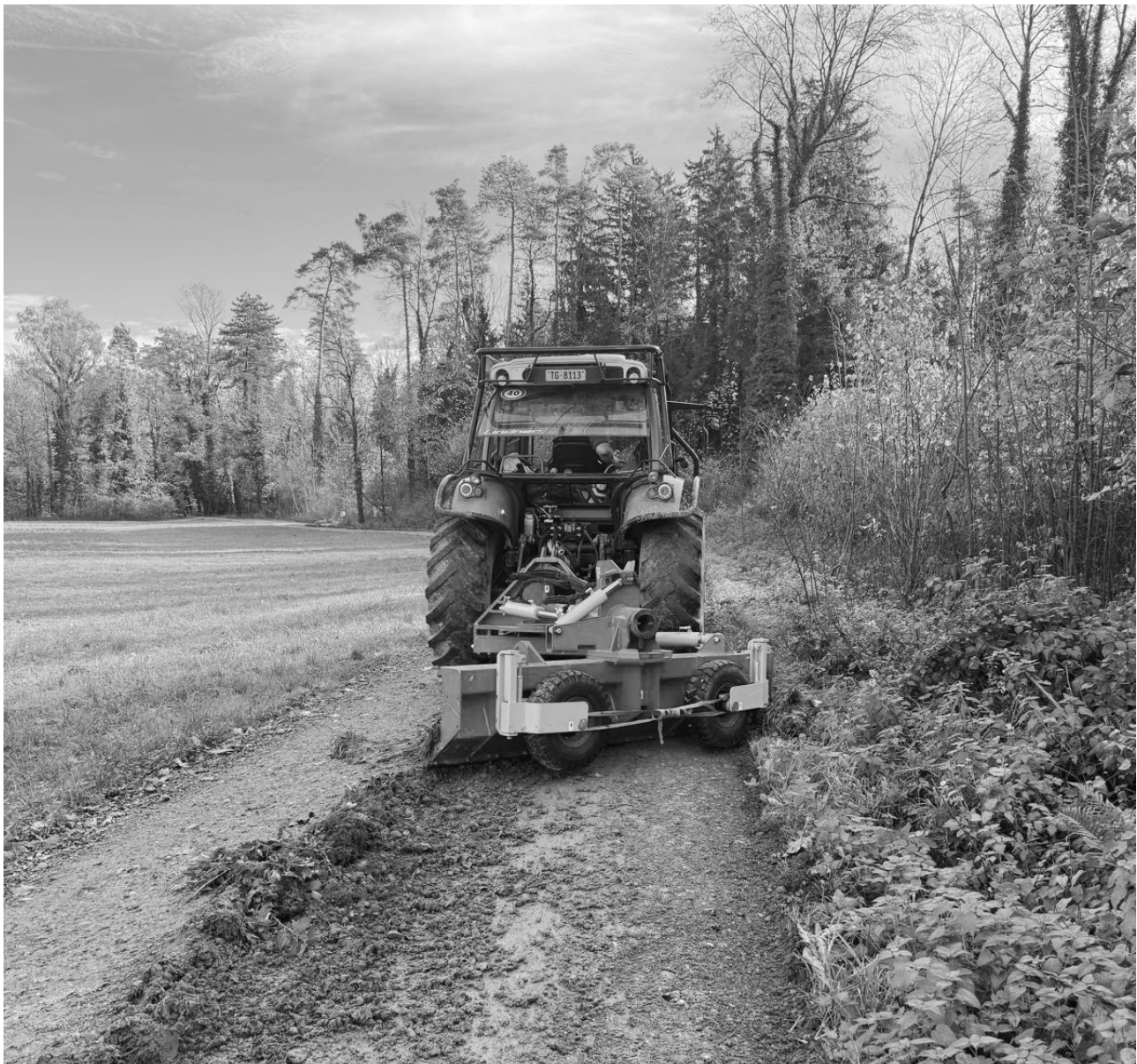
Die Sommermonate wurden für Strassenunterhaltsarbeiten genutzt.
