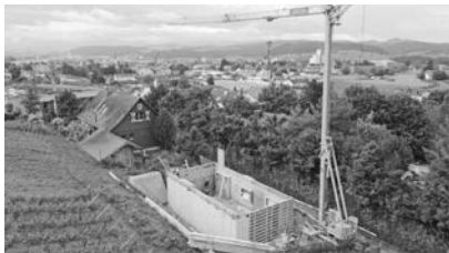
Der Betonunterbau wird erstellt.
