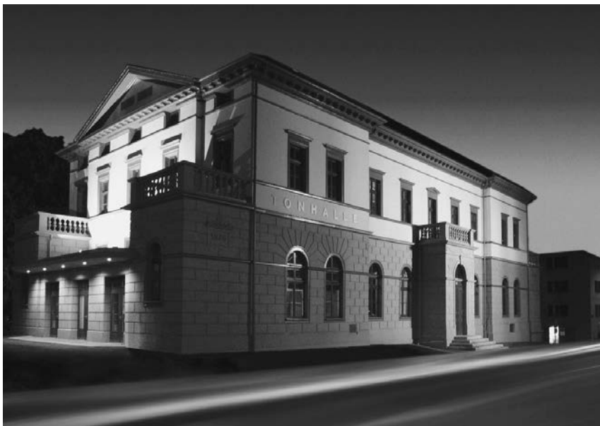
Im Jahr 2025 wird die Beleuchtung in der Tonhalle Wil auf LED umgestellt.
